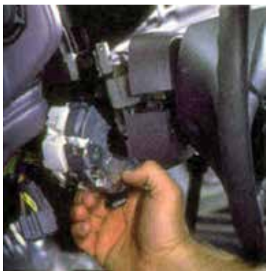
شکل ۱-۹۶- خارج کردن سوئیچ روشنایی از محل خود
