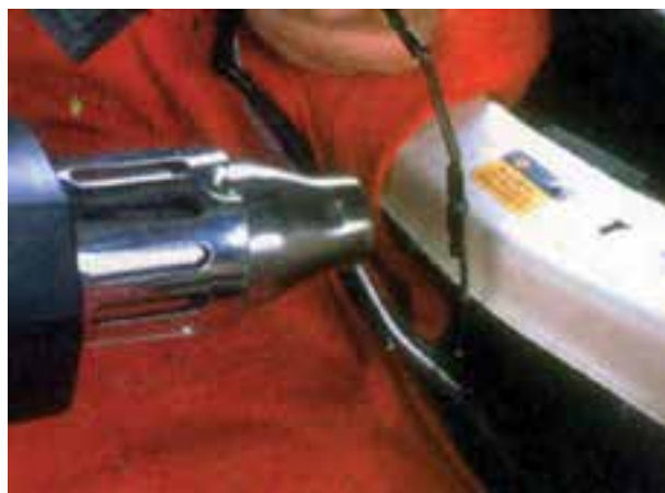
شکل ۱-۱۵۰- عایق کاری محل اتصال سیم ها
