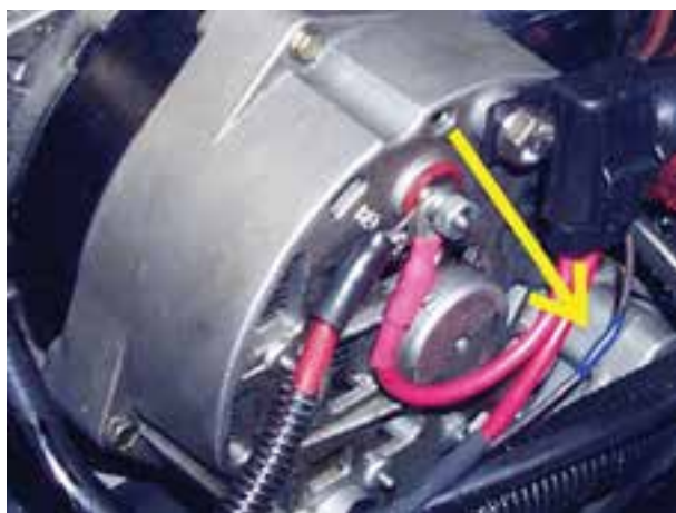
شکل ۲۶-۳- عایق کاری سیم کشی مدار الکتریکی
