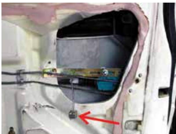
شکل ۳۸-۲- باز کردن بست فلزی از روی میله‌ی قفل کن دستی
