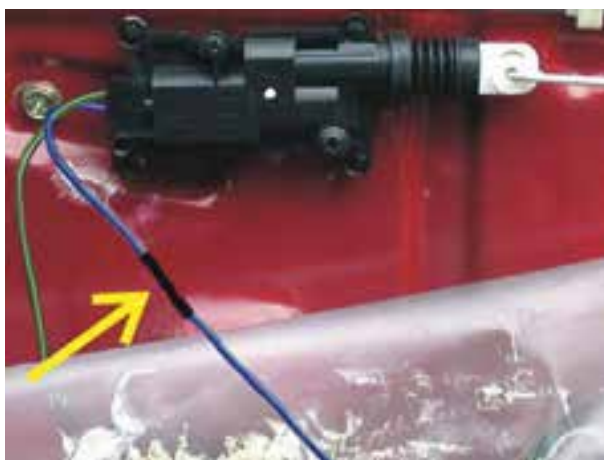
شکل ۲-۴۹- عایق کاری محل اتصال سیم‌ها به یکدیگر
