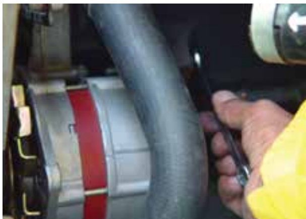
الف - بازکردن پیچ‌های پایه‌ی آلترناتور
