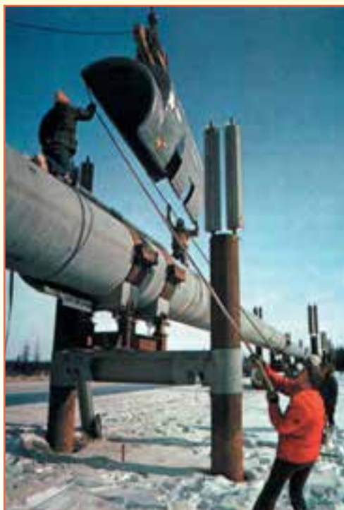
شکل ۶- لوله‌های نفت در داخل جدار گرم‌کننده و بر روی پایه‌ها نصب می‌شود تا از یخ زدن آن جلوگیری کند.
