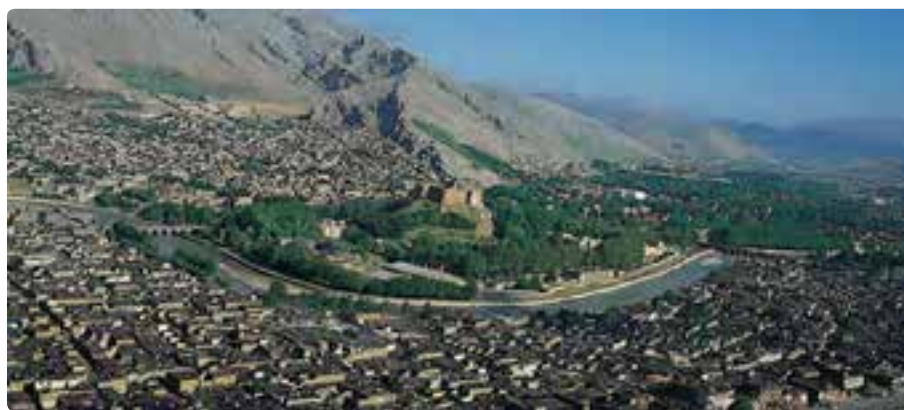
شکل ۲۵-۷- قلعه فلک الافلاک - خرم آباد
