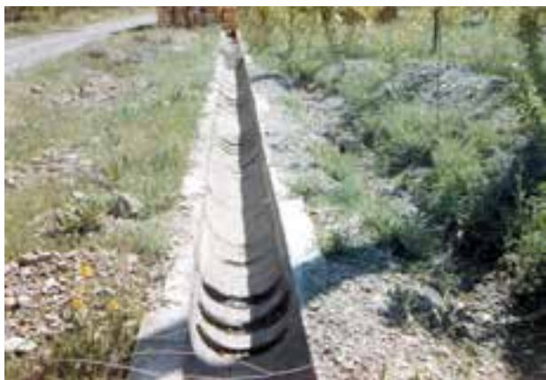
شکل ۲-۲- کانال با مقطع دوزنقه‌ای
