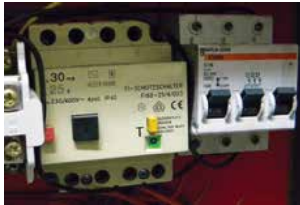
شکل ۱-۴- فیوز حفاظتی نصب شده در کارگاه
