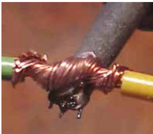
شکل ۱-۴۴- گرم کردن محل لحیم کاری قبل از اضافه کردن لحیم
