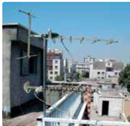
شکل ۱۸-۴ آنتن VHF و UHF روی دکل
