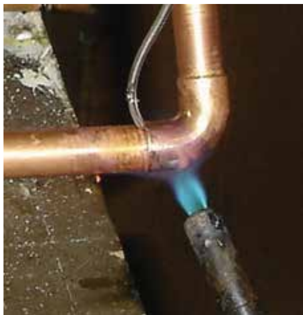
شکل ۱-۵- اتصال لوله‌ی مسی با فیتینگ لحیمی
