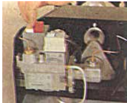
شکل ۲-۳۲- روشن کردن یک نوع مشعل
