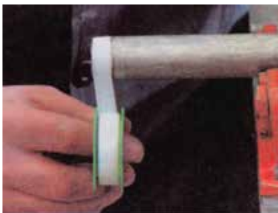
شکل ۶۱-۱- پیچیدن نوار تفلون به سر لوله
