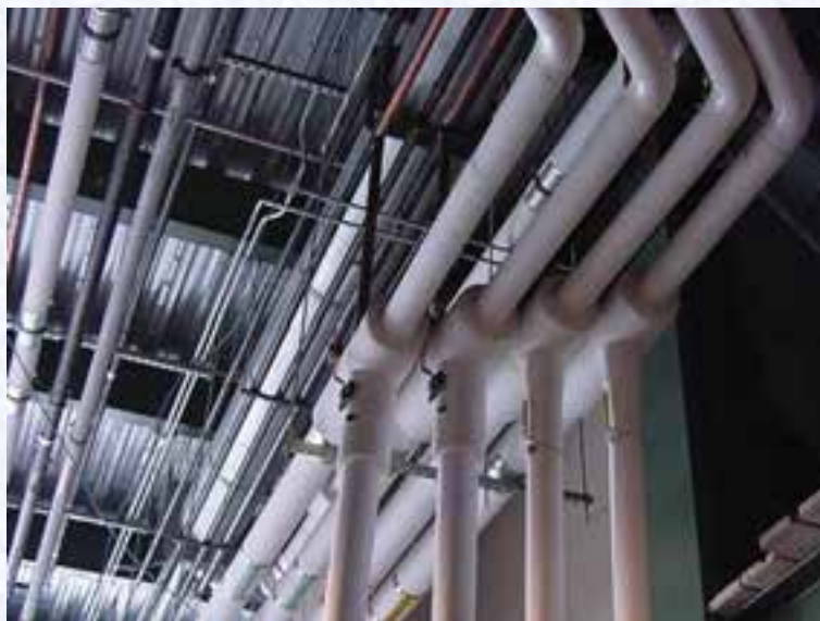
شکل ۳۴-۲- عایق کاری (گرمابندی) لوله‌ها
