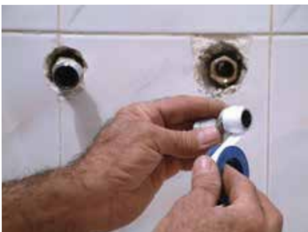
۳- پیچیدن نوار تفلون بر روی دنده‌ی \frac{1}{4} دنباله‌ی شیر
