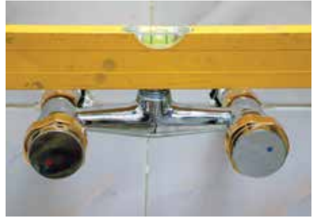
۱۲- سنجش تراز نصب شدن شیر مخلوط به وسیله تراز
