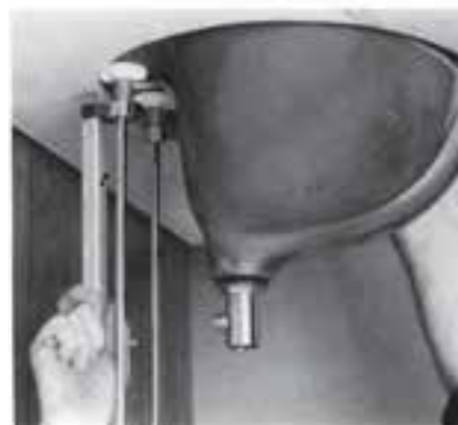
شکل ۱۱-۱۰ الف - شیر مخلوط توکاسه‌ی تک پایه
