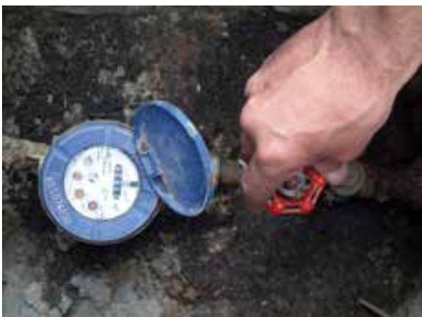
۱- بستن شیر اصلی بعد از کنتور آب
