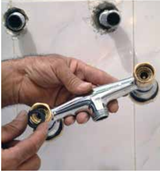
۹- قرار دادن واشرهاي \frac{3}{4} در درون مهره‌هاي \frac{3}{4} تنه‌ي شير
