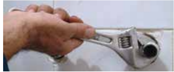
۵- سفت کردن دنباله‌ها با آچار فرانسه
