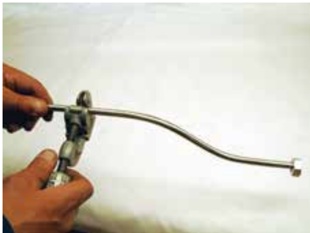
۲- بریدن لوله‌ی پیسوار به وسیله‌ی لوله‌بر
