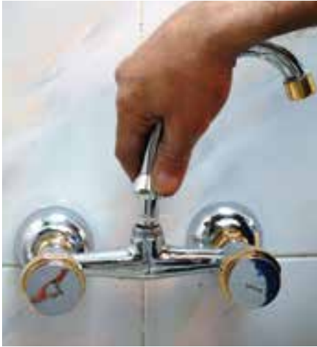
۱۳- جازدن عَلم شیر مخلوط در درون نافى شیر
