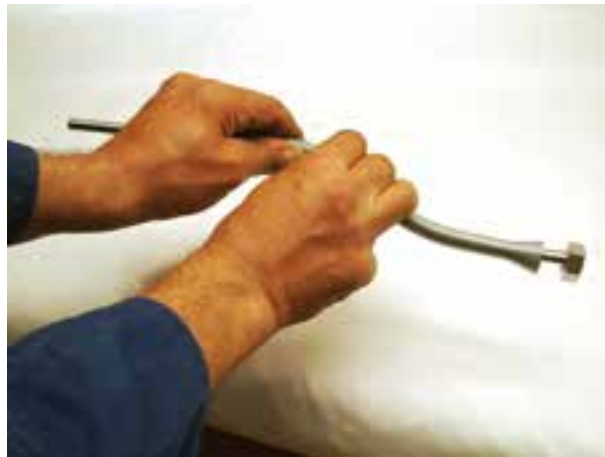
۱- خم زدن لوله‌ی پیسوار به وسیله‌ی فنر
