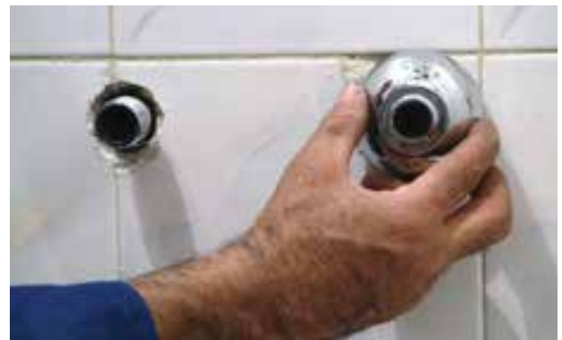
۸- بستن كاسه‌ها (قالباق‌ها) به دنده‌ي \frac{3}{4} دنباله‌ها با دست
