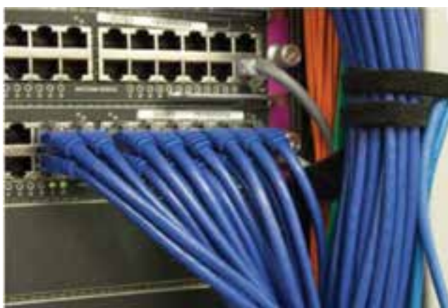
شکل ۲۵-۴- اتصال کابل‌ها به پیچ پانل
