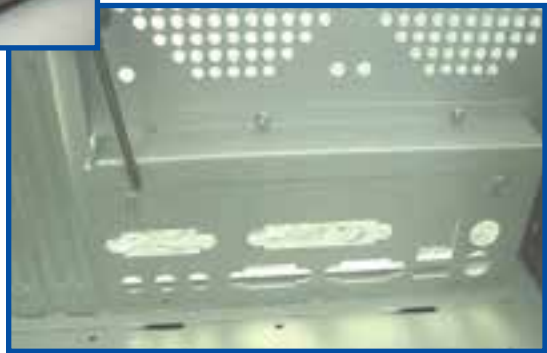
شکل ۸-۱۳ نصب پانل ورودی/خروجی
