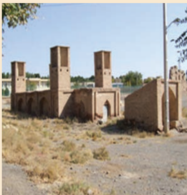
شکل ۳-۴- آب انباری در کوهپایه
