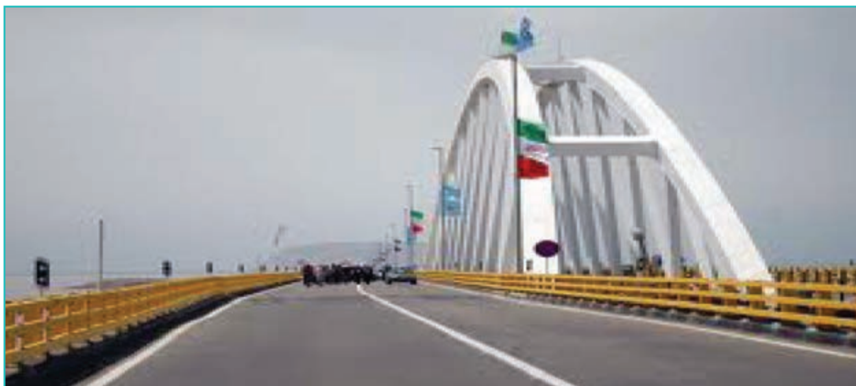
شکل ۶-۶- پل میان گذر دریاچه ارومیه
