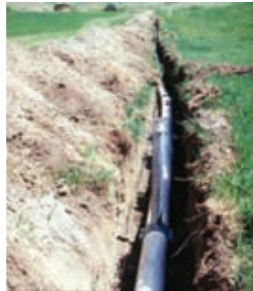
الف) لوله اصلی داخل کانال حفر شده (ب) جایگیری لوله اصلی و رایزر و شیر هیدرانت
