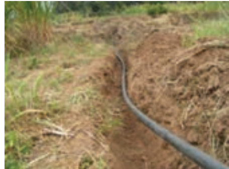
الف) لوله‌های نیمه اصلی داخل کانال حفر شده
