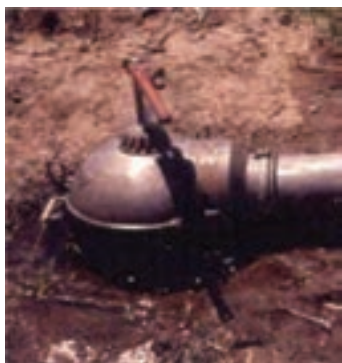
ب) شیر هیدرانت سر لوله زیر زمینی
