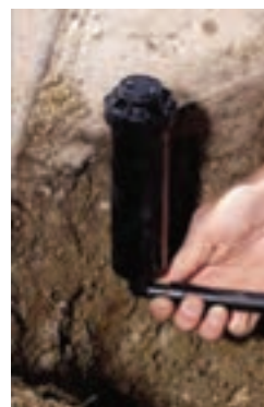
د) نصب آب پاش
