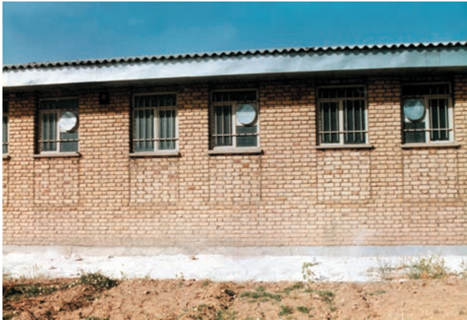
تصویر نمای خارجی یک جایگاه پنجره‌دار
