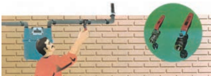
شکل ۴-۲۱- تصویر شیر مصرف گاز
