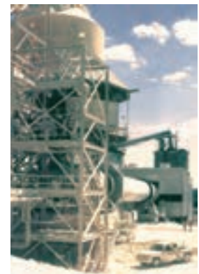
شکل ۸-۹-۸ یک کارخانه مدرن آهک‌پزی: کوره مدرن تبدیل سنگ آهک به آهک در صنایع شیمیایی از اهمیت فراوانی برخوردار است. این ماده ارزان‌ترین باز به‌شمار می‌رود. در تهیهی بسیاری از مواد شیمیایی، هم‌چنین تهیهی مصالح ساختمانی، از جمله سیمان و شیشه به‌کار می‌رود. واکنش تهیهی آن در دمای بالا و در کوره‌ی چرخان بزرگی انجام می‌گیرد که ابعاد آن ممکن است به 15^{\circ} متر و قطر 5 متر برسد.
