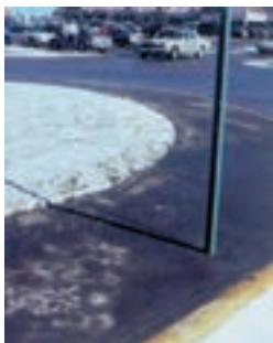
شکل ۸ استفاده از سدیم کلرید برای کاهش نقطه ذوب یخ به منظور ذوب کردن یخ سطح جاده‌ها
