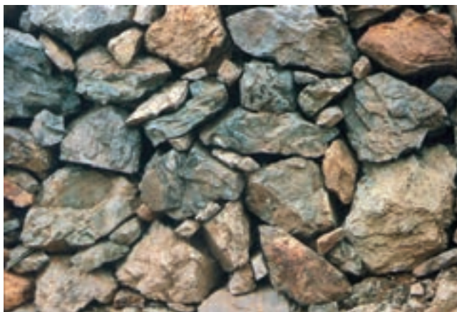
شکل ۸-۲- نمای دیوار لاشه چینی شده بدون ملات
