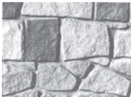
شکل ۱۱-۲- دیوار با سنگ چندوجهی سرتراش رجدار
