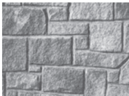
شکل ۹-۲- دیوار با سنگ سرتراش مرتب و بدون رج
