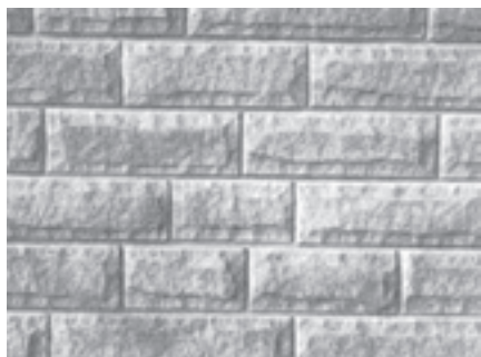
شکل ۱۲-۲- دیوار با سنگ بادبر مرتب و بارج‌های مساوی
