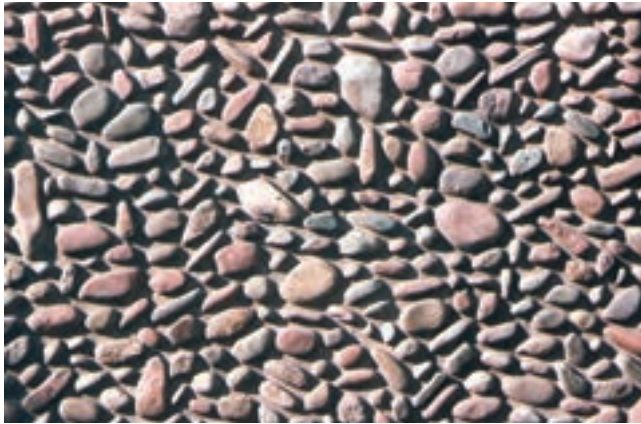
شکل ۶-۲- نماسازی با سنگ قلوه‌ای رودخانه‌ای
