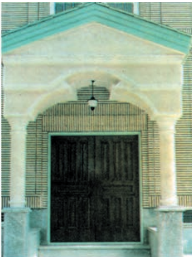
شکل ۲۰-۵ - ستون‌سازی - سرستون‌سازی - قوس‌سازی سه‌کمانه - ابزارزنی - سیمان‌بری
