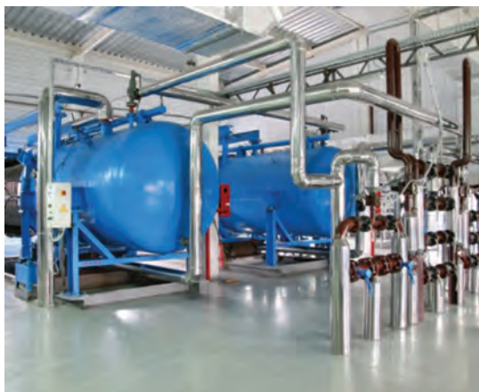
شکل ۱۲- سیستم زمستانه کردن روغن ها
