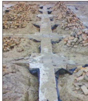
شکل ۳-۱۳۷ پی و شناژ بعد از بتن‌ریزی
