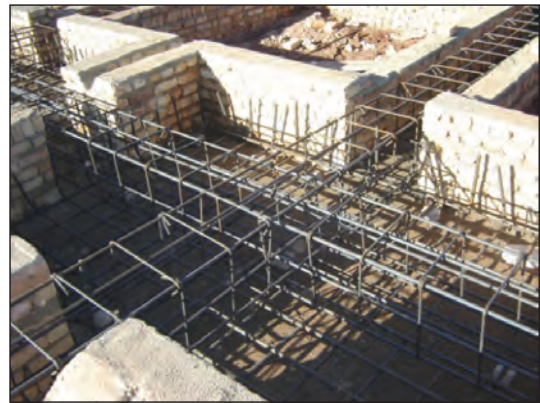
شکل ۳-۱۳۵ عبور میلگردهای شناژ در پی
