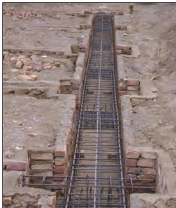
شکل ۳-۱۳۶ پی و شناژ قبل از بتن‌ریزی
