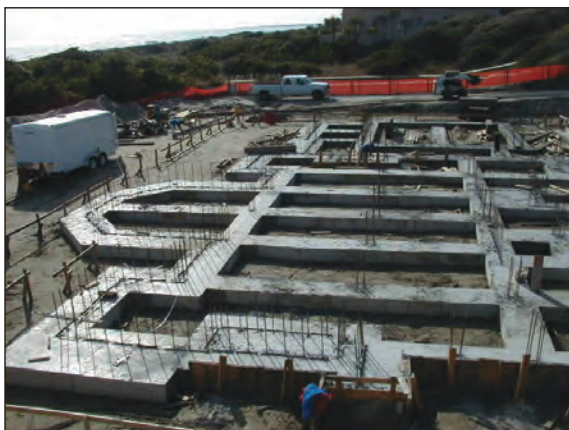
شکل ۳-۶۲ پی بتن مسلح نواری شبکه ای زیرستون
