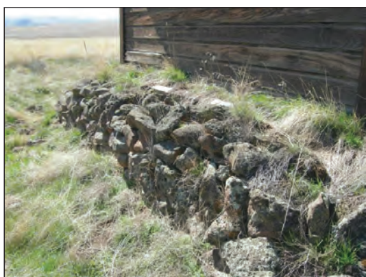
شکل ۳-۴۰ پی سنگی با سنگ لاشه
