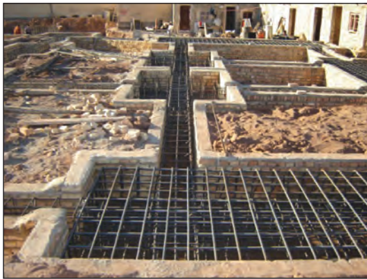
شکل ۳-۱۳۴ میلگردگذاری در پی کلاف بندی
