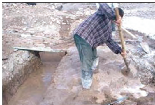
شکل ۳-۳۷ اجرای شفته آهک در فونداسیون
