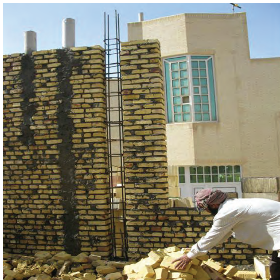
شکل ۱ - ۶۰: اتصال کلاف قائم و افقی در دیوار
