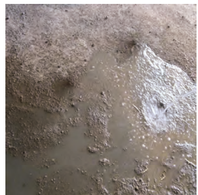
شکل ۱- ۱۰۳: خیس کردن سطح زیر کار
