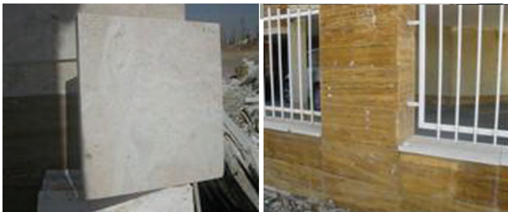
شکل ۱-۱۸ : کاربرد سنگ رسوبی در نما
