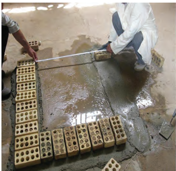
شکل ۱ - ۳۳ (ب): جدا کردن اندازه دو طرف دیگر
