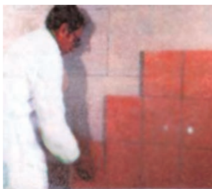
شکل ۱ - ۴۳: نصب کاشی روی قطعات پیش ساخته گچی
