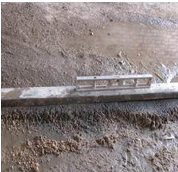
شکل ۱ - ۸۶: کنترل تراز سطح ملات
