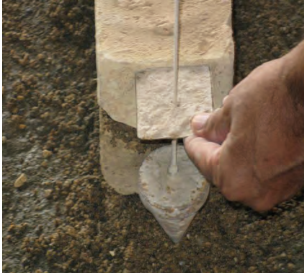
شکل ۱- ۷۷: شاقول کردن نبش کار
