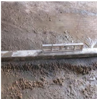
شکل ۱- ۱۰۵: تراز کردن روی ملات
