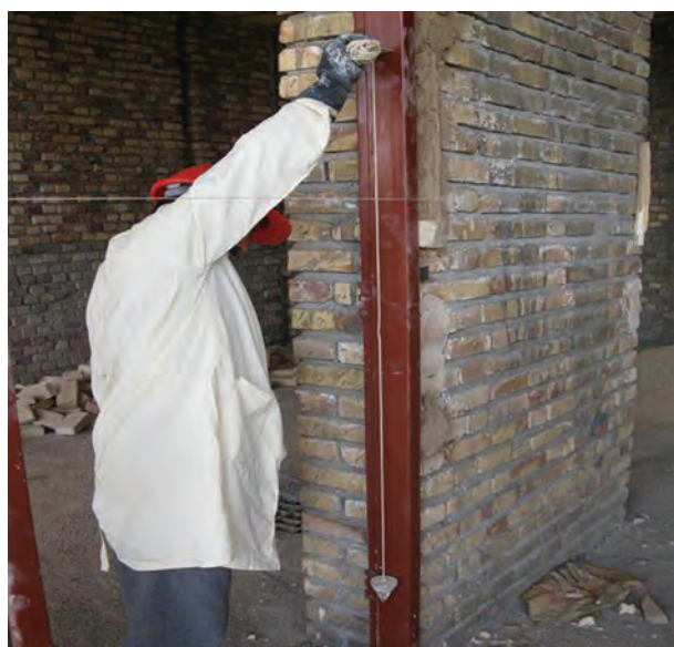
شکل ۳-۲۳: شاقول کردن وادار
