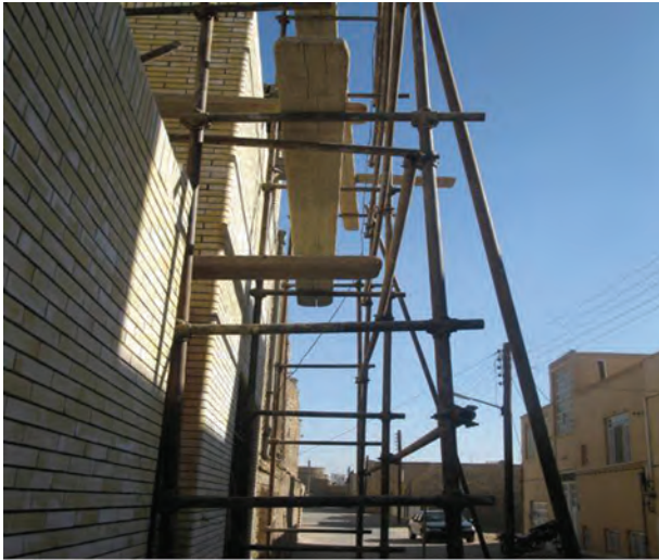
شکل ۱-۱: داربست فلزی برای چیدن دیوار
