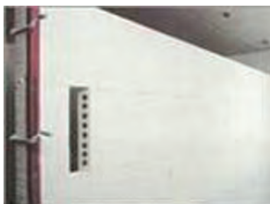
شکل ۱ - ۳۷: دیوار جداکننده با قطعات پیش ساخته گچی
