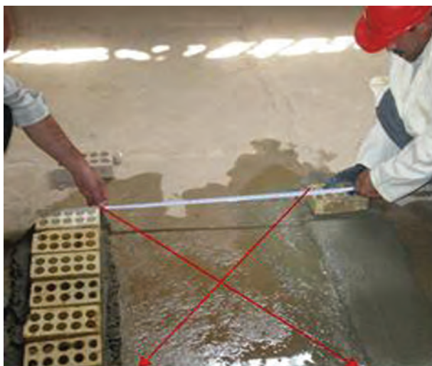
شکل ۱ - ۳۳ (ب): جدا کردن اندازه دو طرف دیگر
