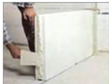
شکل ۱ - ۳۶: طریقه نصب بلوک های گچی
