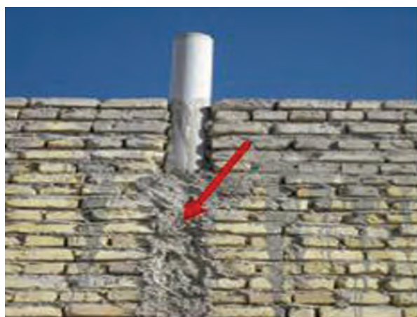
شکل ۱ - ۶۵: پر کردن درز لوله‌ها
