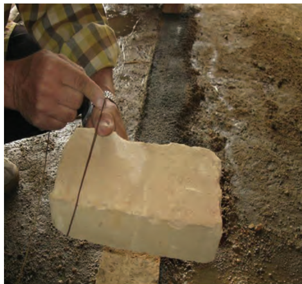
شکل ۸۹-۱: نحوه بستن ریسمان کار به آجر
