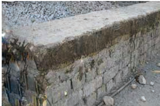
شکل ۱- ۲۹ : کرسی چینی یا عایق کاری رطوبتی
