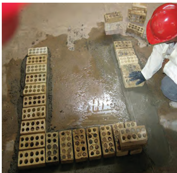
شکل ۱ - ۳۳ (ج): ریسمان کشی و چیدن ضلع سوم
