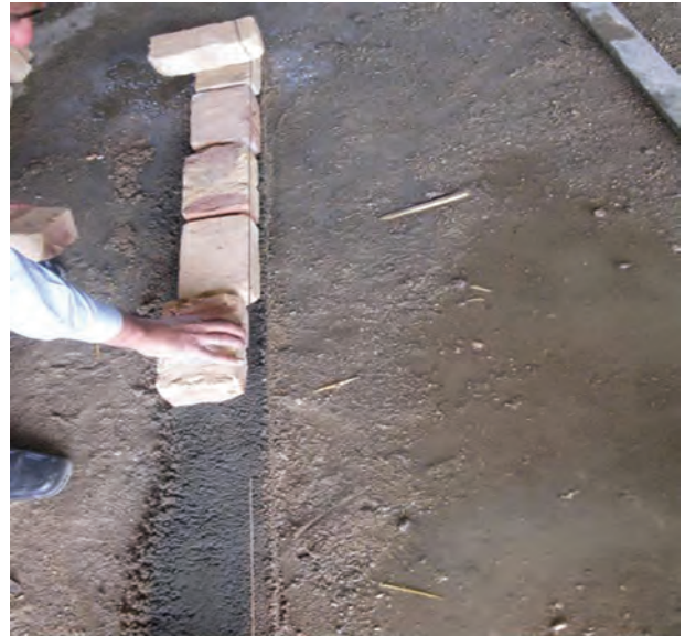
شکل ۱ - ۹۱: نحوه چیدن آجر در امتداد ریسمان کار
