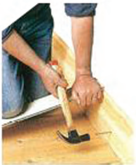
شکل ۳- ۲۹: نصب قرنیز چوبی با میخ
