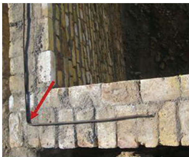
شکل ۱ - ۵۵: میلگرد گذاری در محل اتصال دو دیوار
