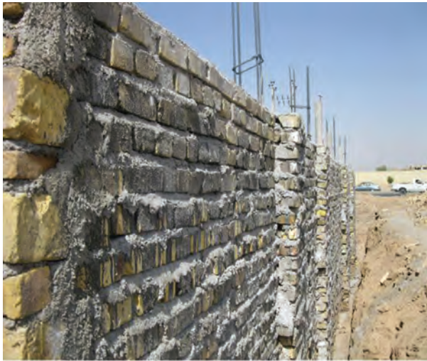
شکل ۱ - ۲۶: دیوار آجری با کلاف بندی قائم
