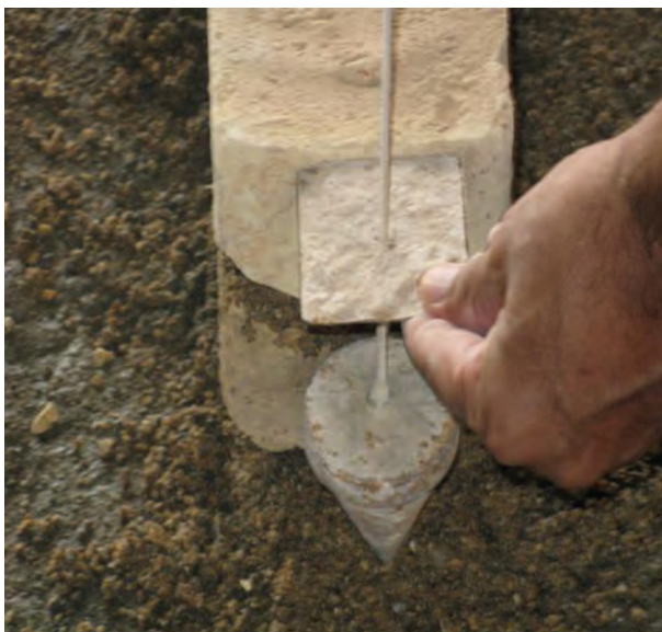
شکل ۱ - ۹۴: شاقول کردن نبش کار
