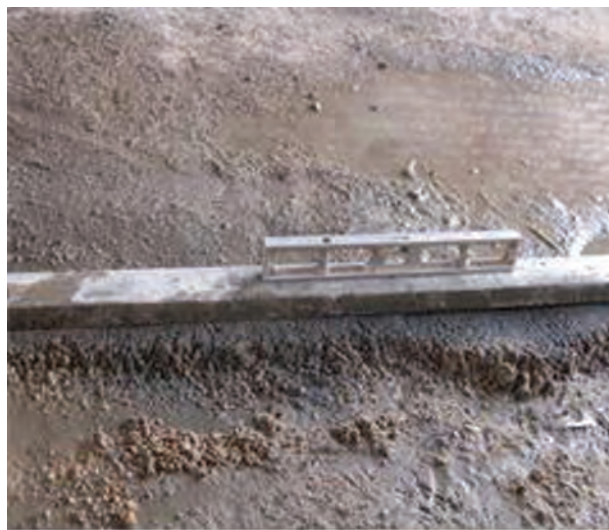
شکل ۱- ۶۹: تراز کردن روی ملات
