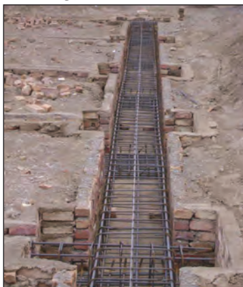
شکل ۳-۱۳۶ پی و شناژ قبل از بتن‌ریزی
