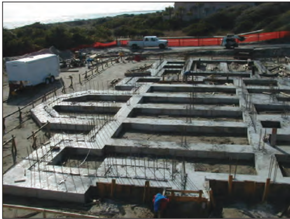
شکل ۳-۶۲ پی بتن مسلح نواری شبکه ای زیرستون
