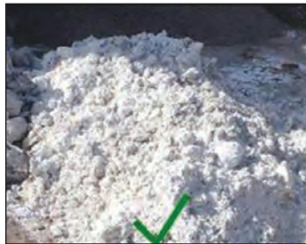
شکل ۳-۳۶ آهک سرند (الک) شده و آماده برای ساخت شفته
