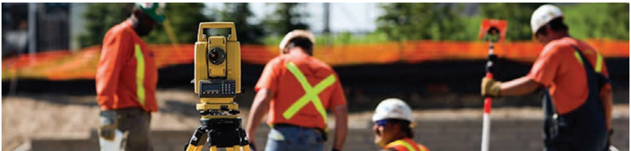
شکل ۴-۱. پیاده کردن با دوربین نقشه‌برداری
