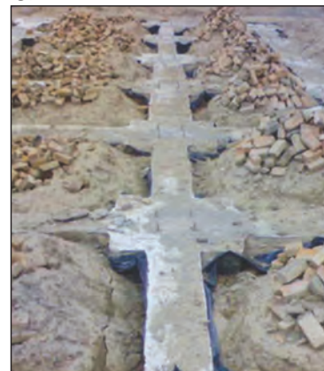
شکل ۳-۱۳۷ پی و شناژ بعد از بتن‌ریزی
