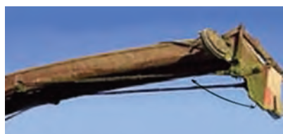
شکل ۵۸- حرکت عمودی کلاهک لوله تخلیه
