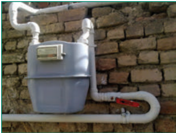
شکل ۸۱-۴ یک کنتور ۱۰ متری نصب شده
