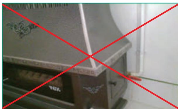
شکل ۴-۱۴ شیر مصرف کننده نباید پشت وسیله گازسوز قرار گیرد
