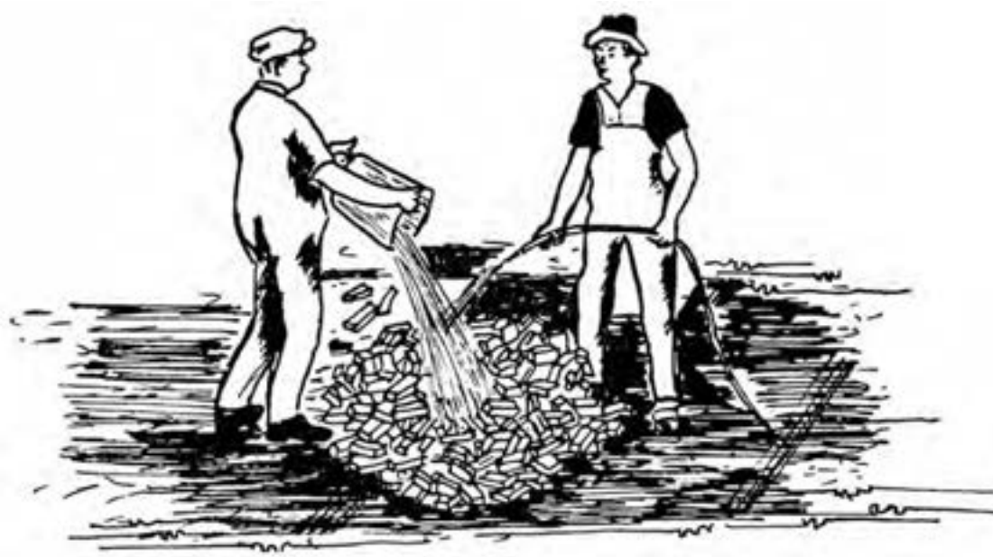
شکل ۳۷ ▲ زنجاب کردن آجر
