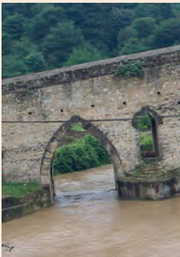
شکل ۱۵ پل شیرگاه مازندران
