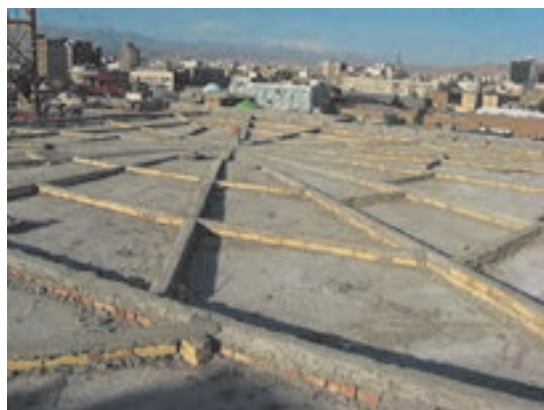
شکل ۱۴ ▲ کرم‌بندی و شمشه‌گیری بین آن‌ها
