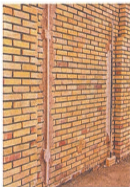
شکل ۲۳ ▲ شمشه‌گیری بین کرم‌ها
