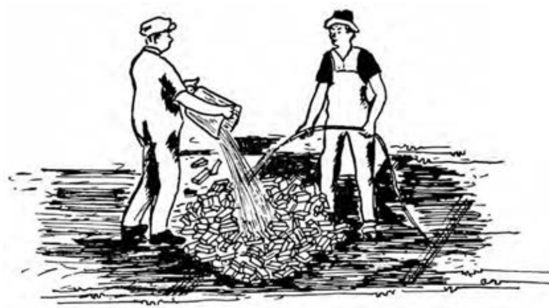
شکل ۳۷ ▲ زنجاب کردن آجر
