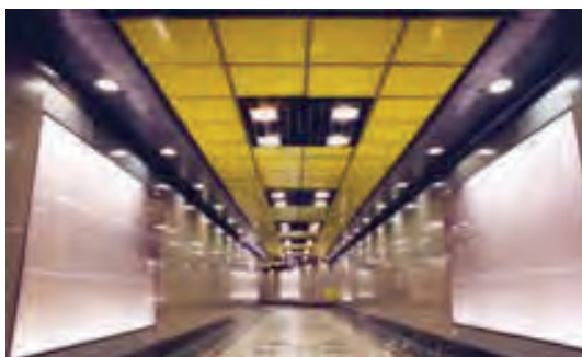
سقف کاذب تایل آلومینیومی با شبکه فلزی
