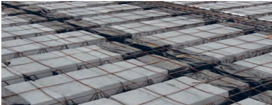
اجرای شناژ مخفی در سقف تیرچه بلوک
