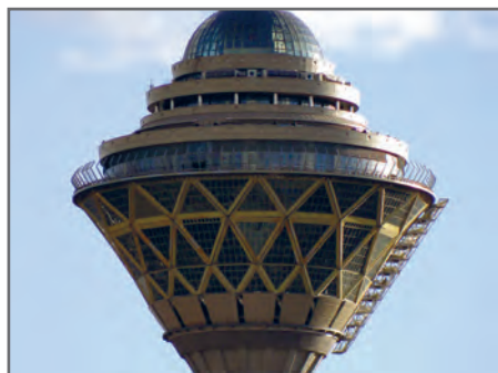
شکل ۱- سازه فلزی برج میلاد تهران
