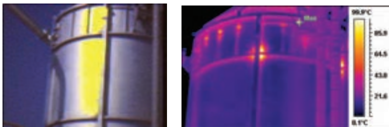
شکل ۱۳- تشخیص نشتی حرارتی از عایق مخازن
