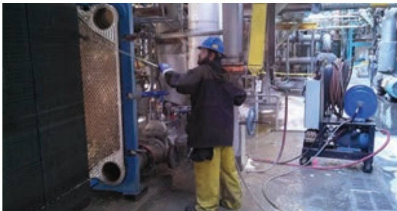
شکل ۱۵- روش فشار آب (جت آب)
