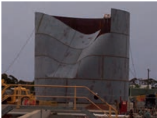
شکل ۴-۲۷- آسیب دیدن مخزن به دلیل وزش باد
