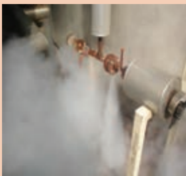
نشتی از اتصال در خط لوله
