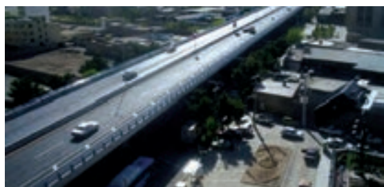
پل روگذر آزادراه از جنس فولاد آلیاژی
