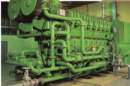
موتور ژنراتور یک نیروگاه برق اضطراری معدن
