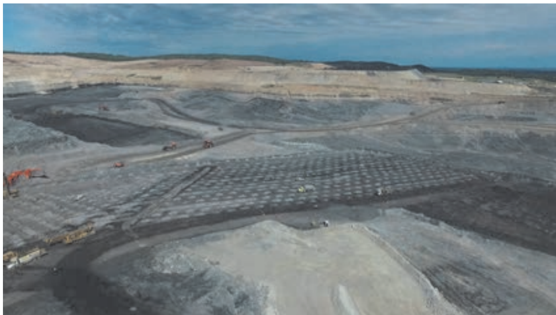
شبکه چال آتشیاری حفر شده
