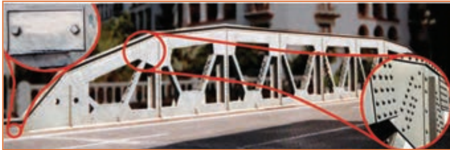
شکل ۳- اتصال دائم : پرچ
