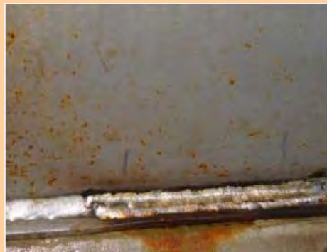
شکل ۴-۶- چگونگی سطوح خورده شده
