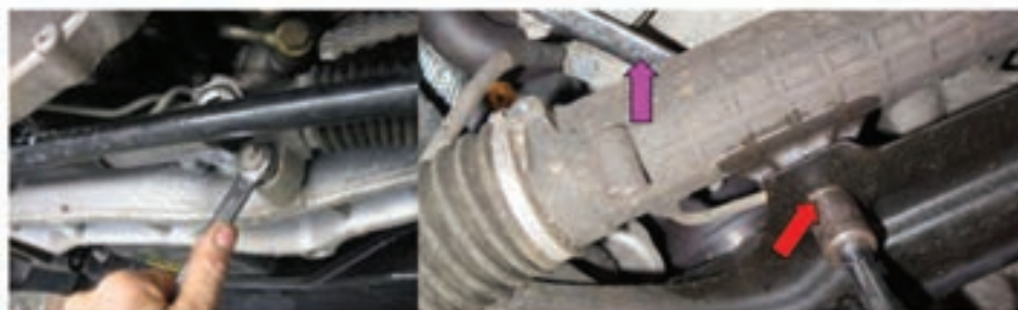
شکل ۲۰ - سفت کردن اتصالات جعبه فرمان
