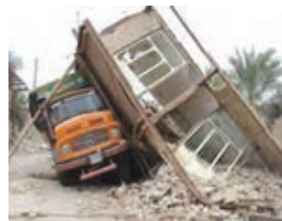
الف) ریزش دیوار در اثر زلزله
