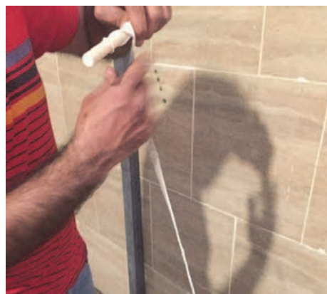
شکل ۶۷- پیچیدن نخ ها روی چوب ماسوره
