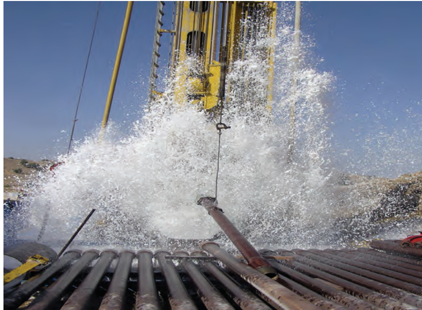
شکل ۲۴-۱- حفر چاه برای تأمین آب مورد نیاز
