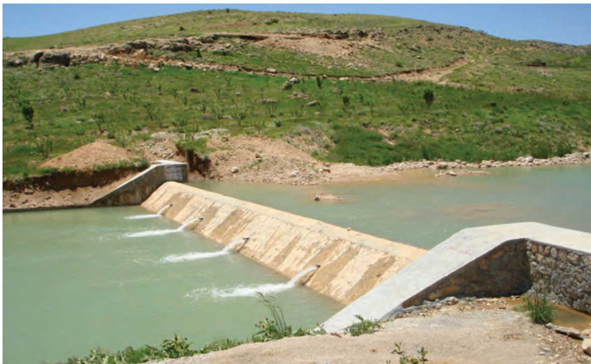
شکل ۲۶-۱- پروژه آبخیزداری بندسنگی ملاتی سرچنار
